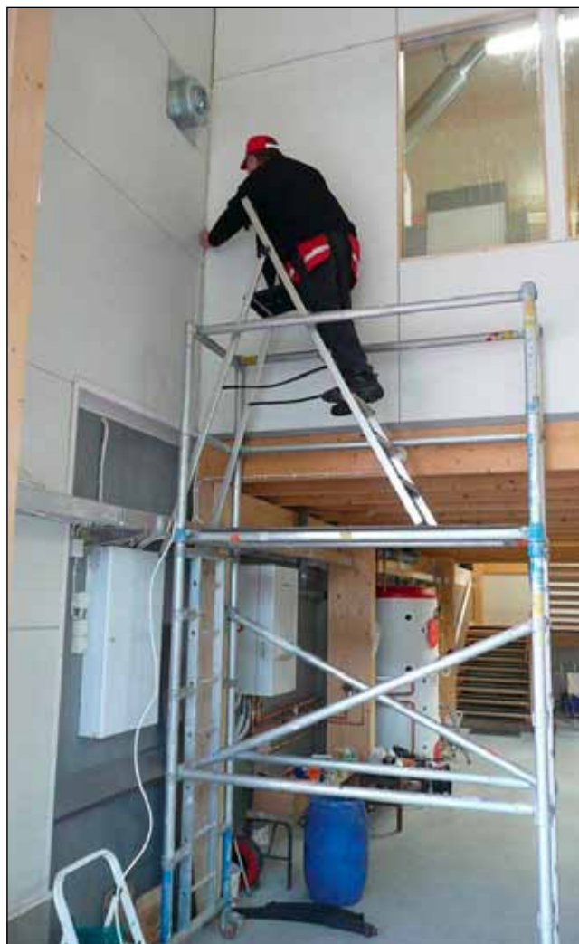
Hannu Hietala asentamassa seinäpuhallinta, työturvallisuusvakuudeksi muut katsoivat ettei vaan putoa.
