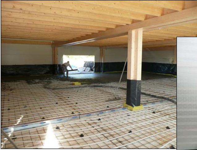
Lattiavalut teki Lahden Betonilattiat OY, kuvassa näkyy lattiaan talkoomiesten toimesta laitettu lämmitysvesiputkisto.
