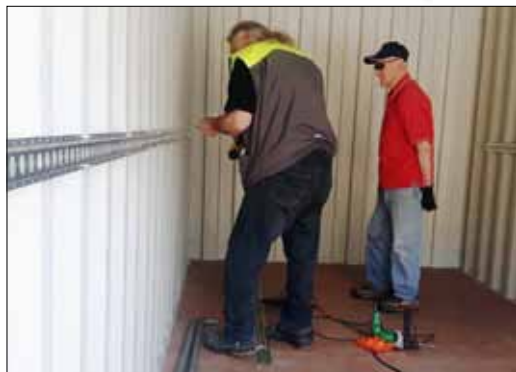
Juha Suomi kiinnittämässä sidontaliinoille kiskoja kontin seiniä, Kalevi Saarinen neuvoa ja valvoo toimitusta.
